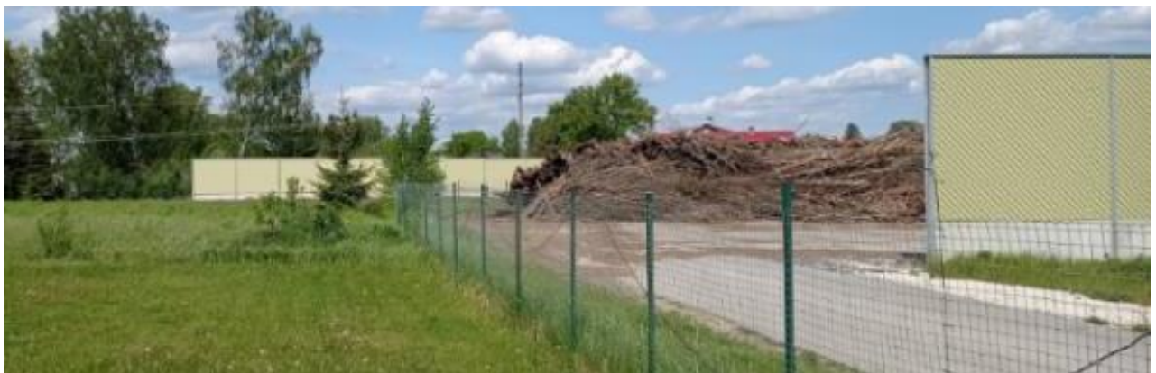
Joonis 4. Müratõkkeseinad Jaama 8 käitlusplatsil, mai 2025.
